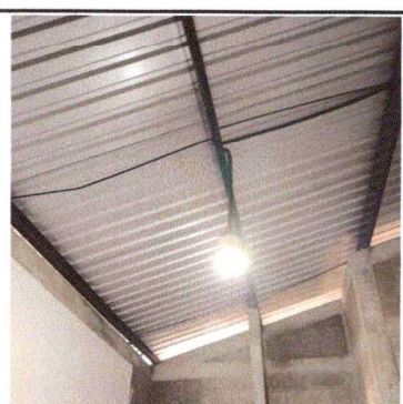
Foto 4: Intalacion de cables y accesorios nuevos
