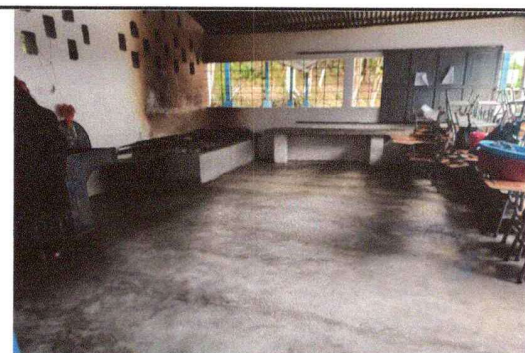
Foto 5. Piso de torta instalado de la cocina
